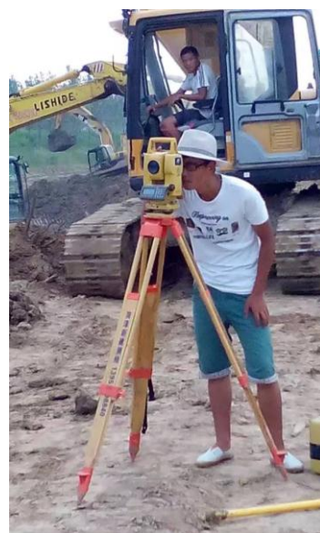
图 12-6 高忠领在施工现场
